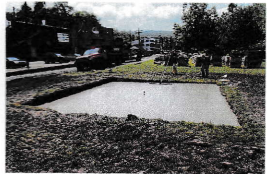
*** Pouring & Leveling the Concrete
