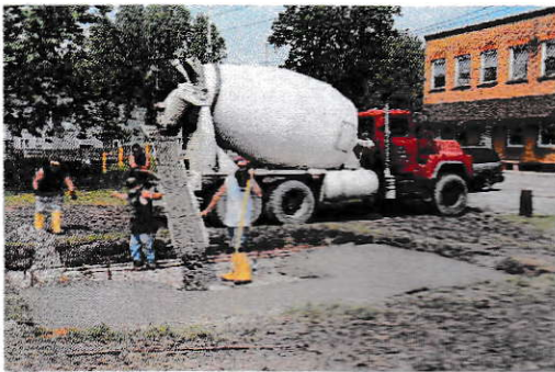
*** Pouring & Leveling the Concrete
